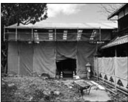
修復中の祠堂
